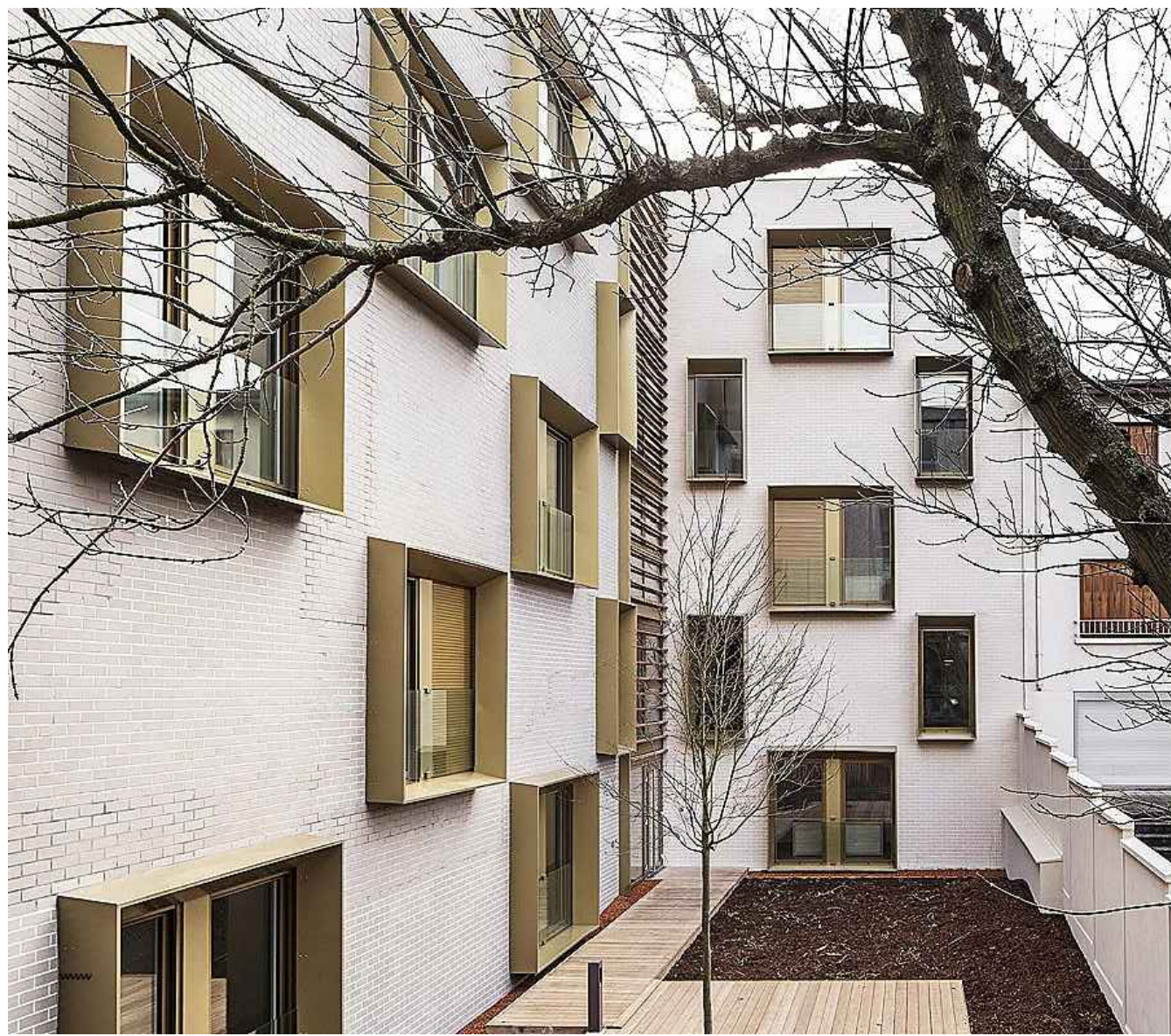
2. Casa dello studente a Soeaux, Francia (CoBe Architekt)
