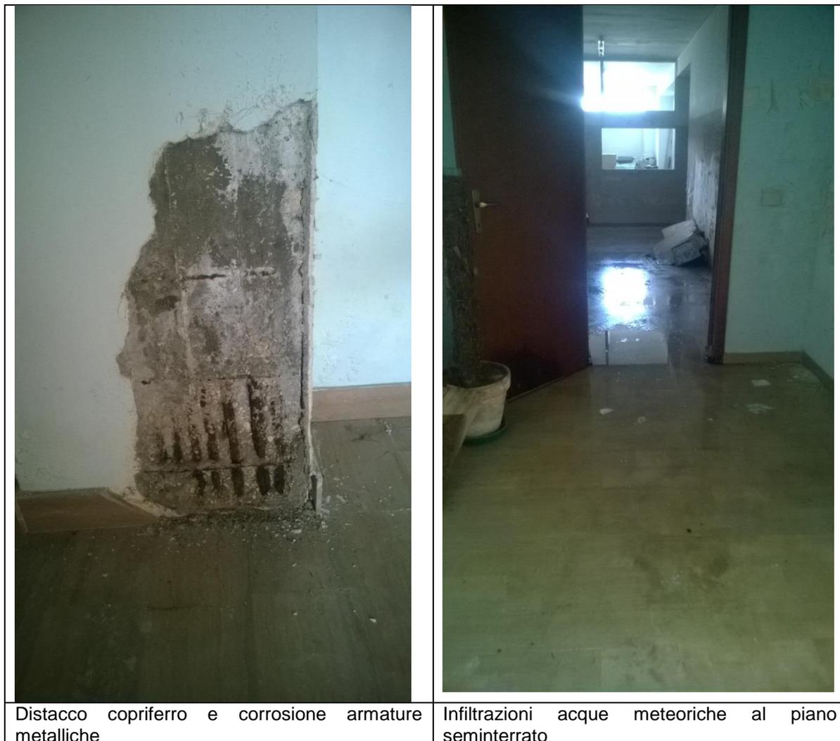
essere riconducibili a problemi statici della struttura o a cedimenti di fondazione apprezzabili. Sono visibile invece, nella porzione del seminterrato Lotto E-Lotto D , segni di degrado degli intonaci e del calcestruzzo dei pilastri, con parziale distacco del copriferro ed esposizione delle armature metalliche. Tale circostanza riguarda solo alcuni elementi al piano seminterrato e sono la conseguenza di infiltrazioni di acque meteoriche facilmente eliminabili.
